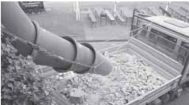
Der Bauschutt muss ordentlich entsorgt werden
