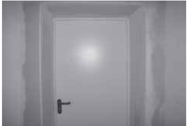
Die Tür ist jetzt neu eingebaut
