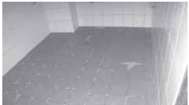
Boden und Wände wurden neu gefliest
